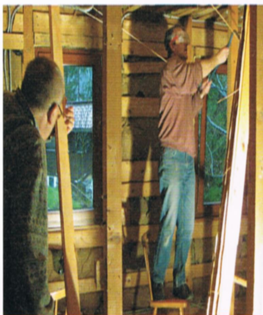
Vorher - nachher: Zahlreiche Helfer haben die Schlafräume im Haus 34 im Kolping-Feriendorf Ebnit modernisiert.
