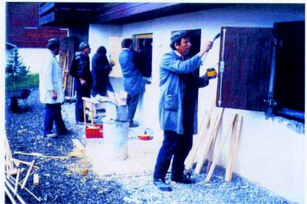
Zwei Fenster werden in die vorbereiteten Öffnungen eingesetzt, die Fensterläden angeschlagen und auch gleich gestrichen. Auch wurde der E-Wasserboiler im Untergeschoß Haus 34 mit Fichtenriemen verschalt.
