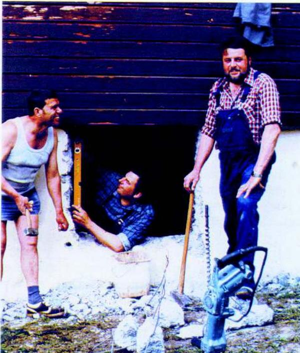
Wieder zieht uns die Arbeit ins Untergeschoß des Musikerhauses. Im kleinen Schlafzimmer (Stockbett) soll ein Fenster eingebaut werden. Zuerst muß dazu die Betonwand ausgebrochen werden. Bei Fussenegger in Dornbirn wird ein Fenster gekauft und eingesetzt. Ebenso wird der Türsturz vom Aufenthaltsraum zum großen Schlafzimmer (Doppelbett) ausgebrochen.
