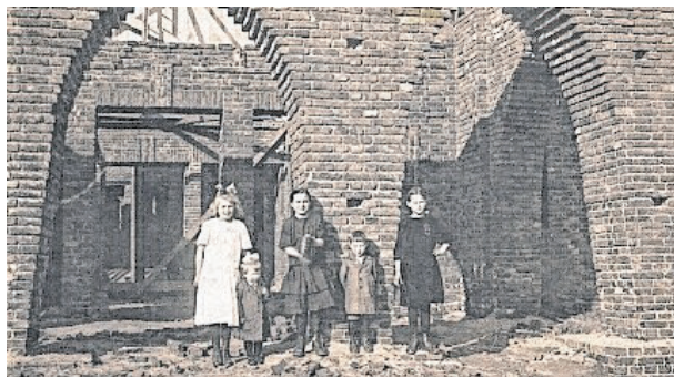
Ein Bild vom Bau des Gotteshauses, bei dem auch die Kinder aus der Nachbarschaft geholfen haben.
