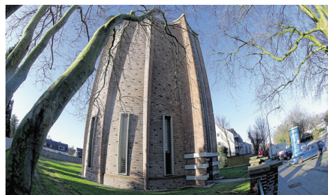
2000 Kubikmeter fasst der Frillendorfer Wasserturm. Auch er wurde von Edmund Körner entworfen und zählt zum Ziegelsteinepressionismus.
