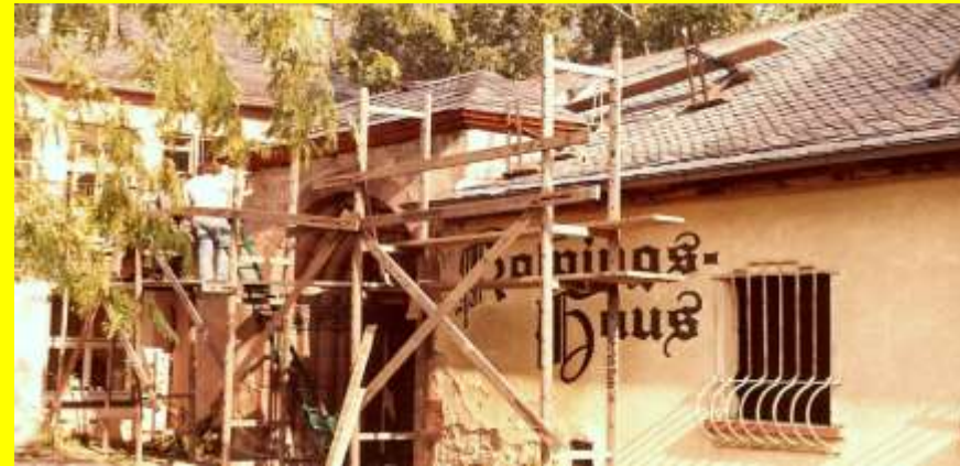
Der Anbau ist in vollem Gange.
