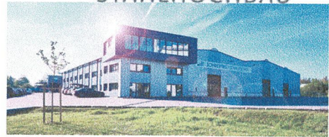
SCHWEVERS STAHLHOCHBAU GmbH & Co. KG, Wöhrmannstraße 27, 47546 Kalkar
