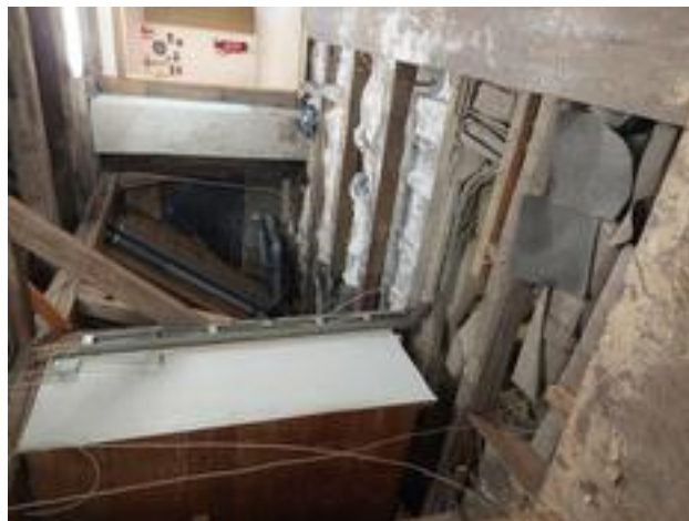
Abbildung 2.19: Impressionen während der Baumaßnahmen im Dachgeschoss
