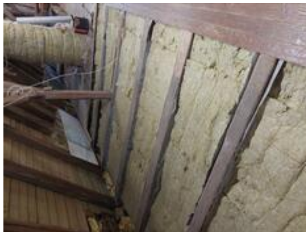
Abbildung 2.20: Impressionen während der Baumaßnahmen im Dachgeschoss
