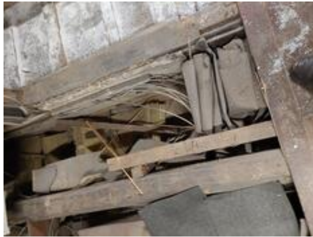
Abbildung 2.18: Impressionen während der Baumaßnahmen im Dachgeschoss
