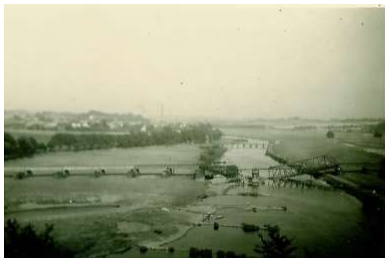
Die zerstörten Eisenbahnbrücken oben nach Dahlhausen, unten nach Steele Süd
