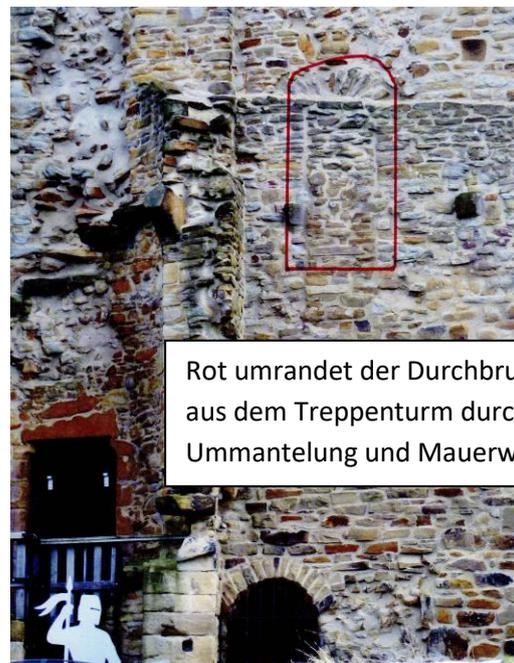
Rot umrandet der Durchbruch aus dem Treppenturm durch Ummantelung und Mauerwerk
