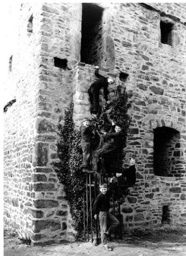
Das Foto aus den 1950er Jahren zeigt seitlich unter dem ursprünglichen Eingang die zwei Löcher, in dem die tragenden Balken für den Erker steckten
