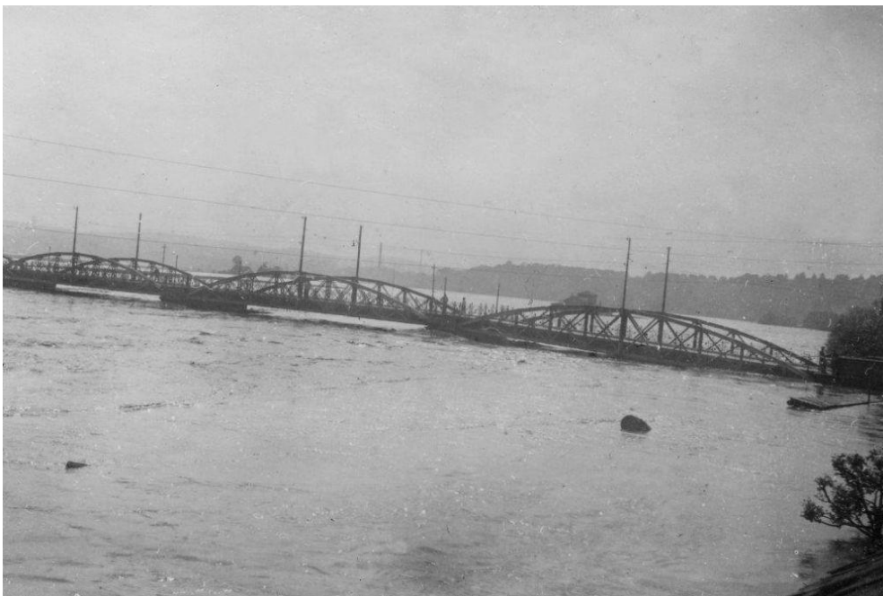
Das überflutete Ruhrtal am 17.5.1943 im Bereich der Steeler Ruhrbrücke
