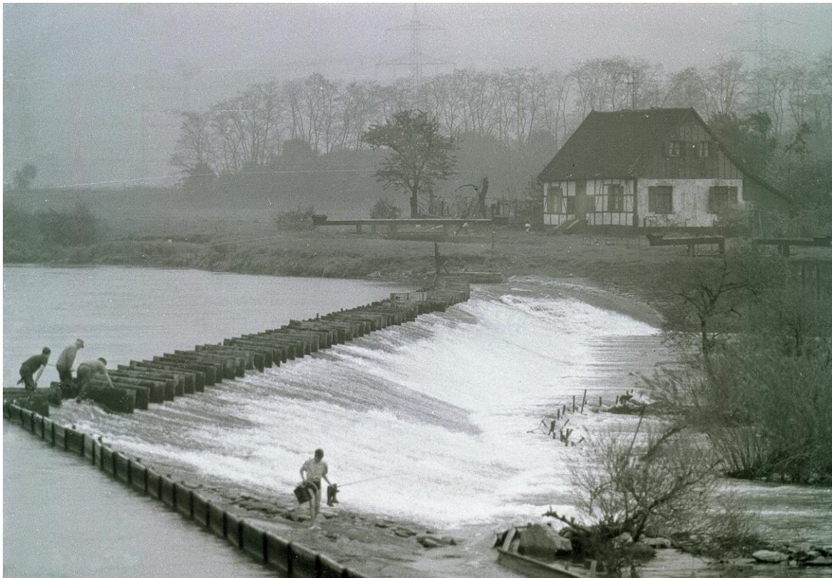
Wehr, Schleuse und Schleusenwärterhaus
