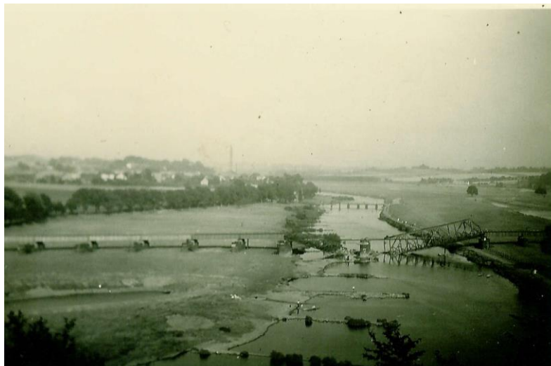
vorn die gesprengte Eisenbahnbrücke Steele Süd – Altendorf, dahinter, noch unversehrt, die Holteyer Brücke
