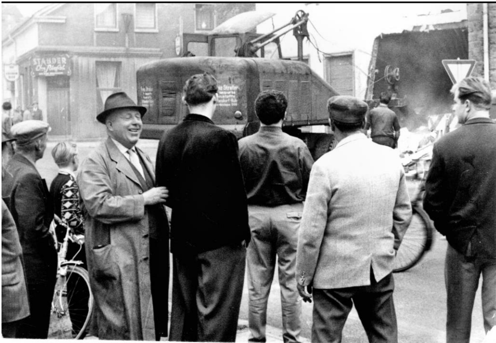
August 1963: Der Abbruch beginnt
