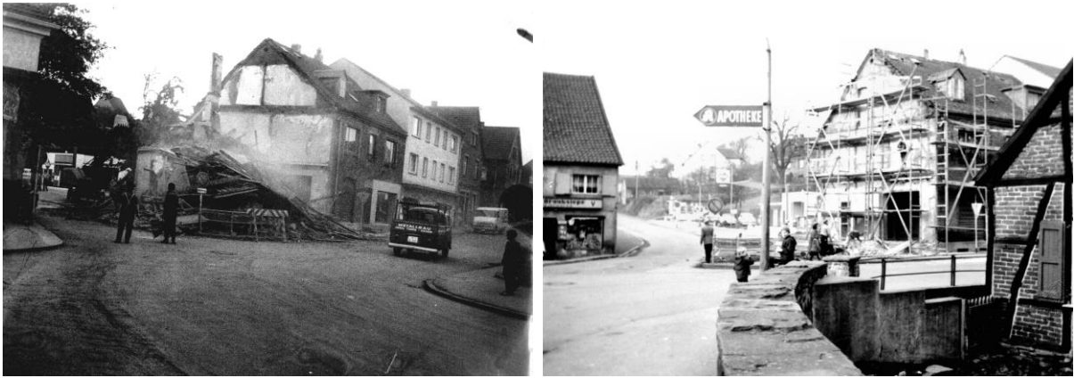
Das Eckhaus liegt am Boden, das verbleibende ist eigerüstet
