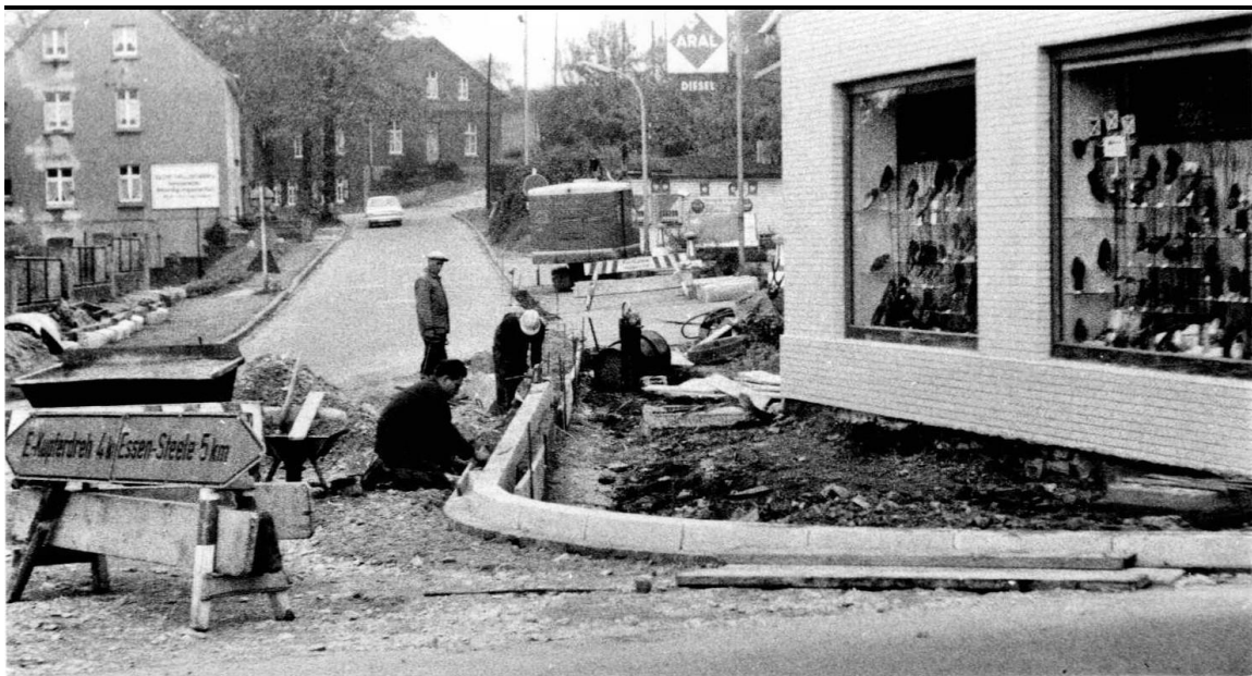
anstelle des abgerissenen Hauses – das Schuhgeschäft Köster
