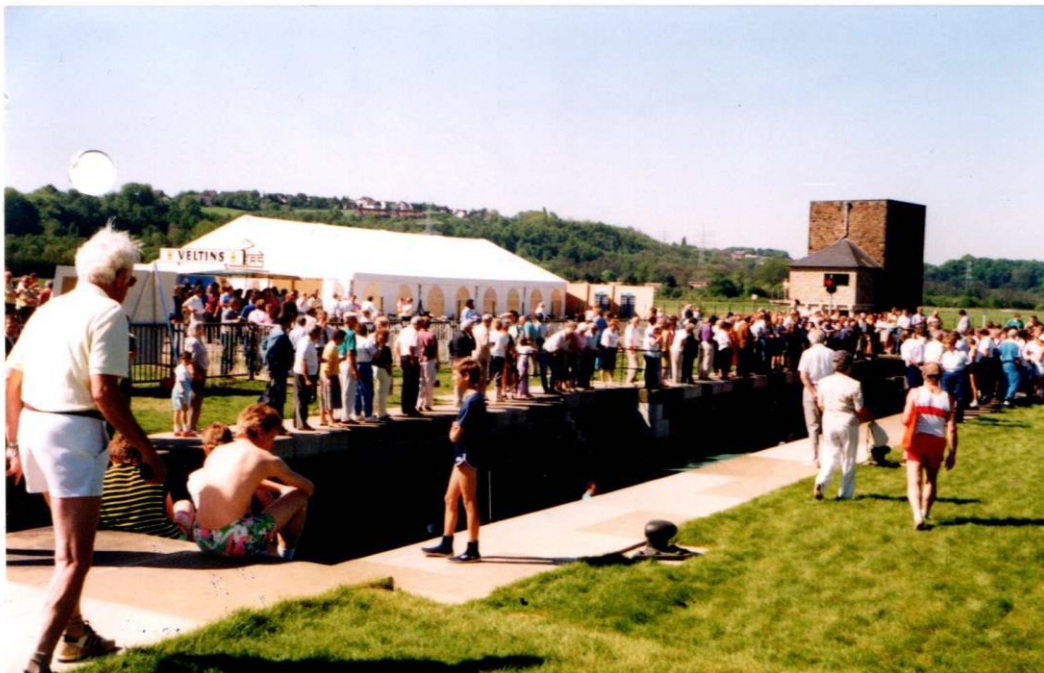
Einweihung der sanierten Schleuse
