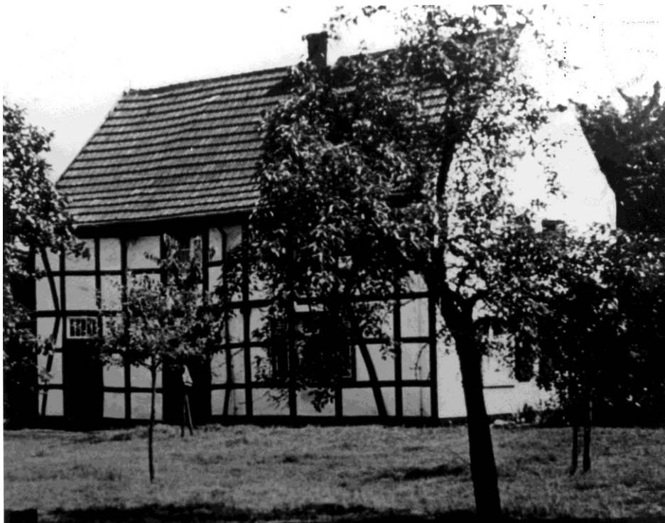
Das Elternhaus von Hugo Spengler an der heutigen Worryngstraße (nicht mehr vorhanden)
