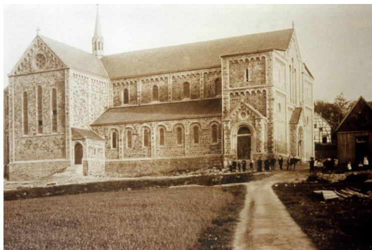
Die Kirche nach dem ersten Bauabschnitt – ohne Türme
