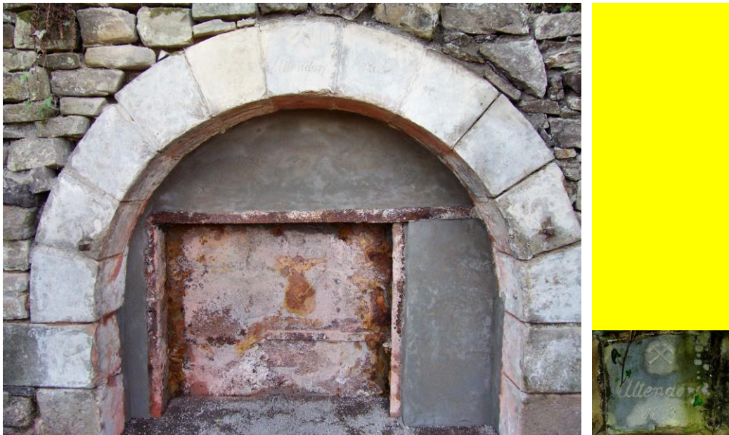
Der letzte sichtbare Stolleneingang von vielen, daneben der Abschlussstein mit Schlägel & Eisen, dem Namen der Zeche Altendorf und die Jahreszahl 1863
