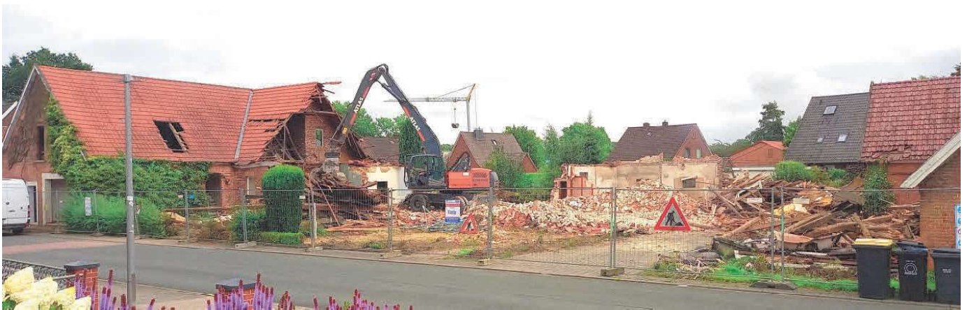
Abrissarbeiten am 19. August 2021 – Die Dom-Bar: ein Trümmerhaufen
