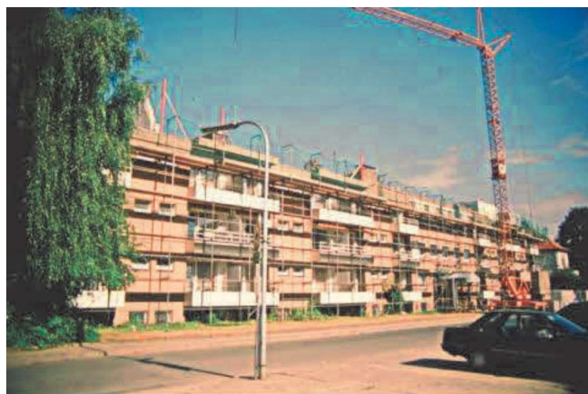
▲ 1994 Zur Schaffung einer Kurzzeitpflegestation wurde auf das bisherige Flachdach ein Dachgeschoss gesetzt. Die Inbetriebnahme der sieben Kurzzeitpflegeplätze erfolgte am 22.5.1995.
